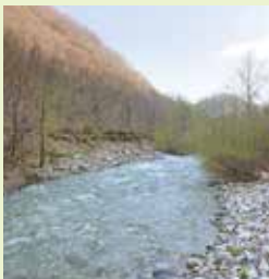
いつの日も氾濫が予測される百瀬川 護岸工事を早期に着実に
