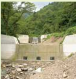
杉尾地区の谷止工 近年のゲリラ豪雨等から山の崩壊。土砂の流出を防いでます。まだまだ必要です
