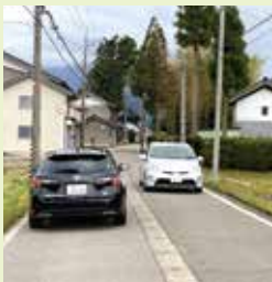
拡幅改良が待たれる県道井波福野線 飛騨屋地内
